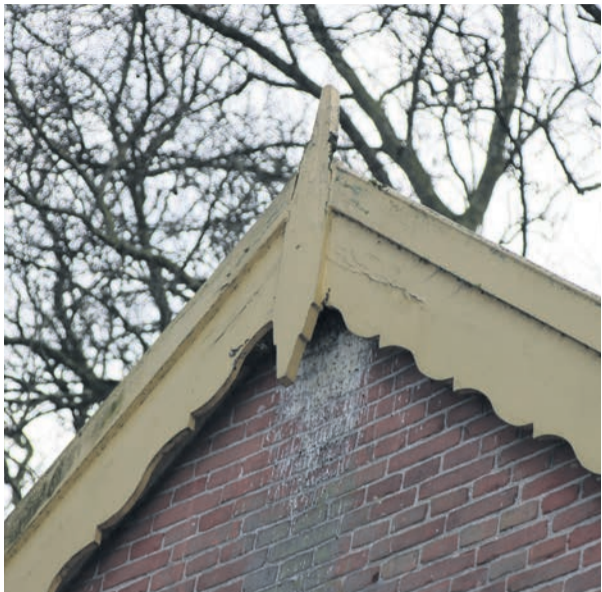
De verflaag was volkomen op, en hier en daar waren ook met de ondergrond problemen
