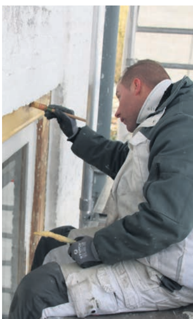
Roy Giezenaar aan het werk. De muurverf wordt in het voorjaar aangepakt
